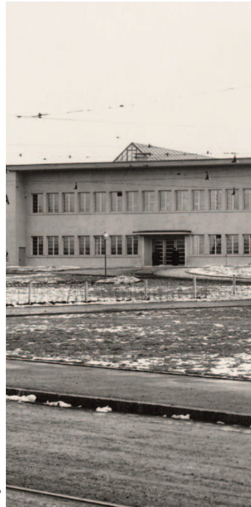
Baugeschichtliches Archiv der Stadt Zürich
